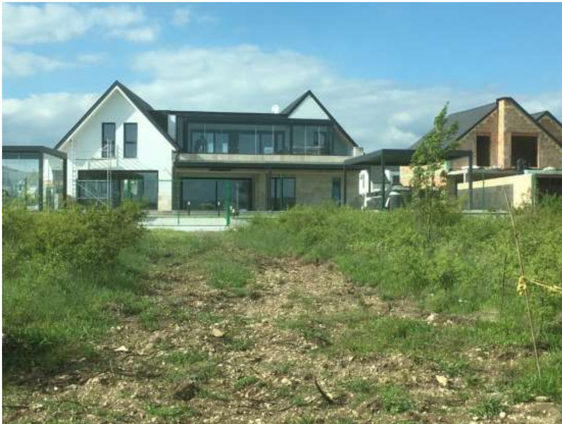
Balatonakali, a parttól kb. 200 m-re. újjépítésű lakóépület
